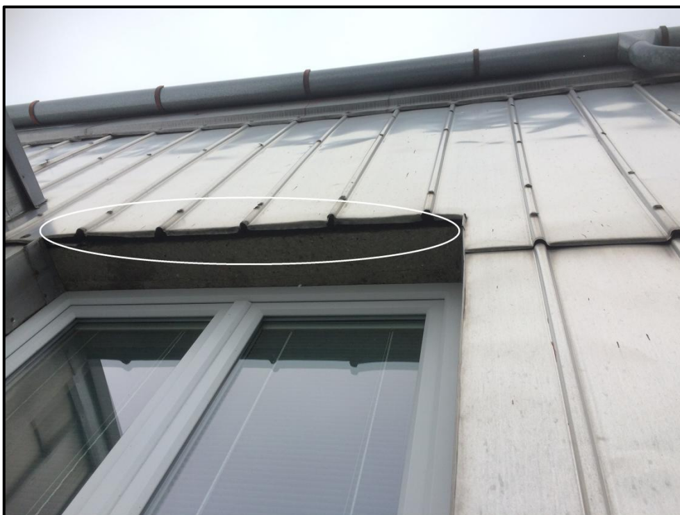
Obr. 2: Dutina pod starým zateplením (elipsa) na JZ straně budovy – potenciální stanoviště netopýrů
