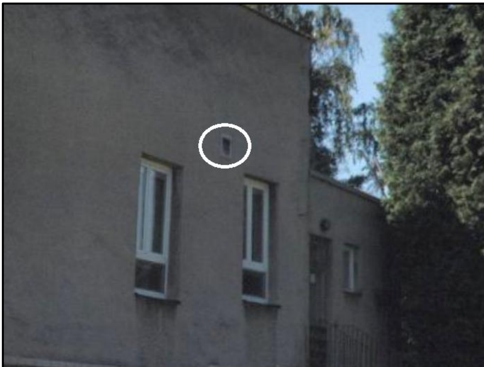
Obr. 1: Ventilační otvor s porušenými lamelami (elipsa) na východní straně budovy – potenciální hnízdiště pěvců (foto: www.mapy.cz)
