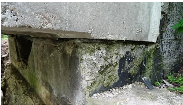
Opěra 1 – křídlo K1L. Uložení nosníků bezložiskové.
