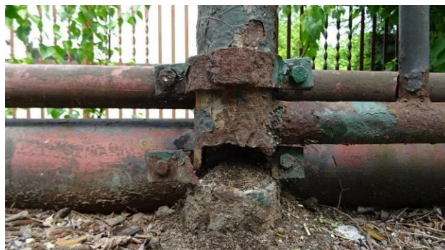
Urezlá trubka sloupku levého zábradlí.
