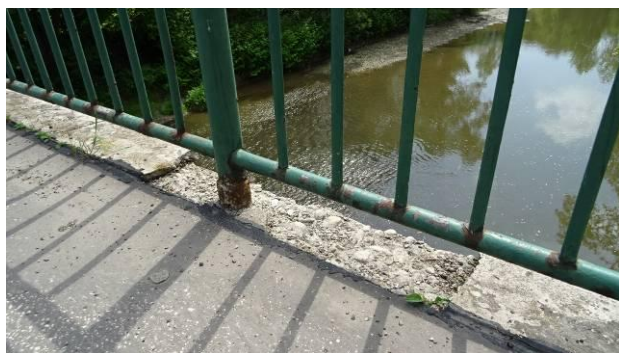
Pravá římsa – rozpad betonu římsy.
