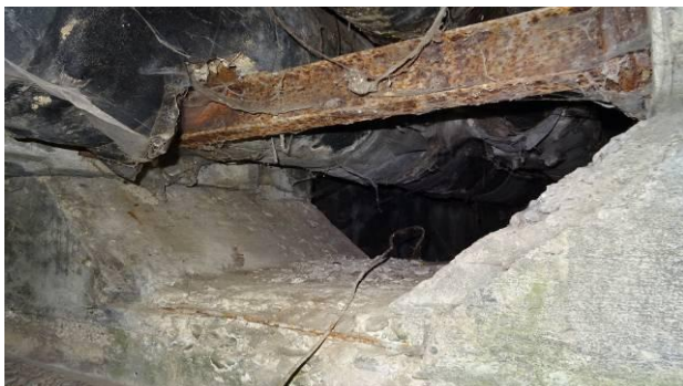
Ocelový příčník pro uložení potrubí – dále je OPP. Celoplošná koroze OPP.
