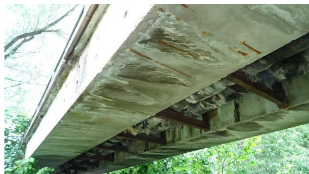
Podhled NK v poli 1. Na celém podhledu NK jsou stopy po zatékání z mostovky.
