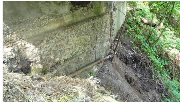
Spodní část OP1 – obnažená trubka chráničky.
