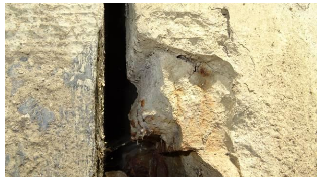
Obnažená kotva předpětí pravého nosníku nad OP1.
