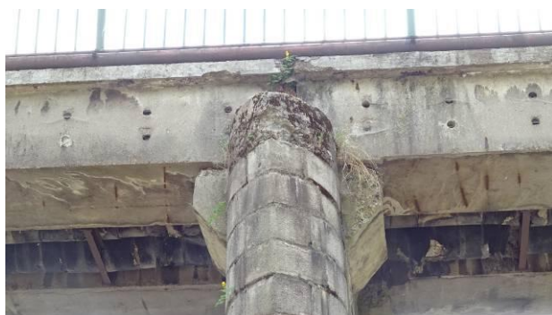
Úložné konzola na podpěře P3.
