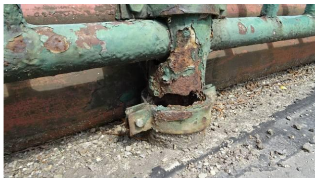
Zcela prokorodovaná trubka sloupku zábradlí.
