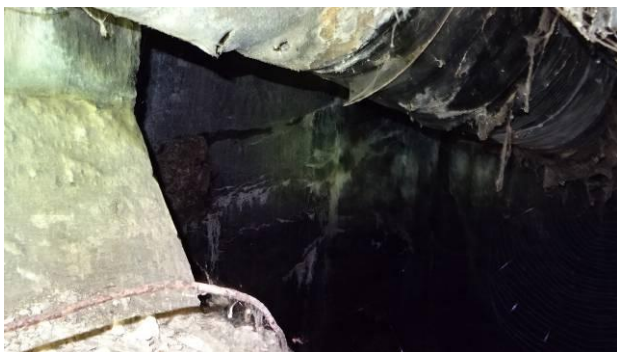
Komora OP1 – pravá stěna. Průsaky a výluhy stěnou křídla K1P.
