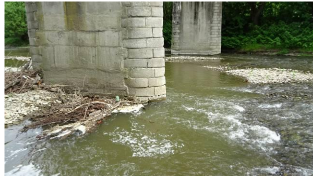
Spodní část P2. Před pilířem podpěry je zahloubené dno.
