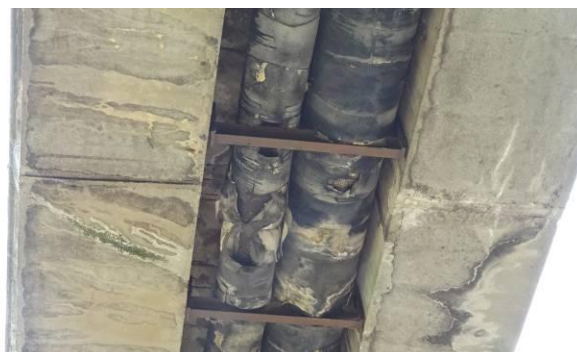
Podhled NK v poli 1 – výluhy v příčné spáře pravého nosníku MPD
