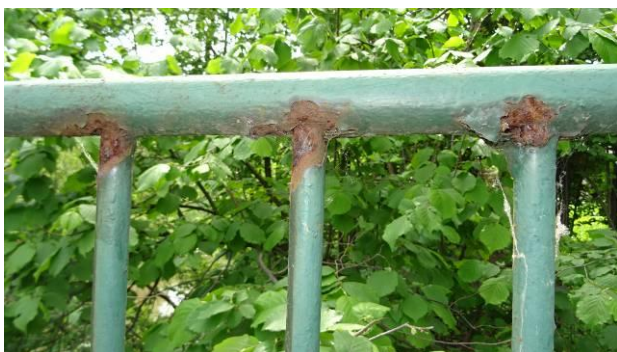
Styk výplně zábradlí s horním madlem.
