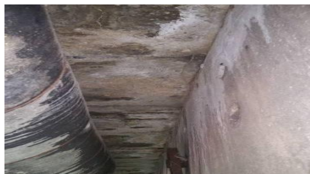
Podhled betonové mostovky nad podpěrou P2. Zatéká všemi spárami.
