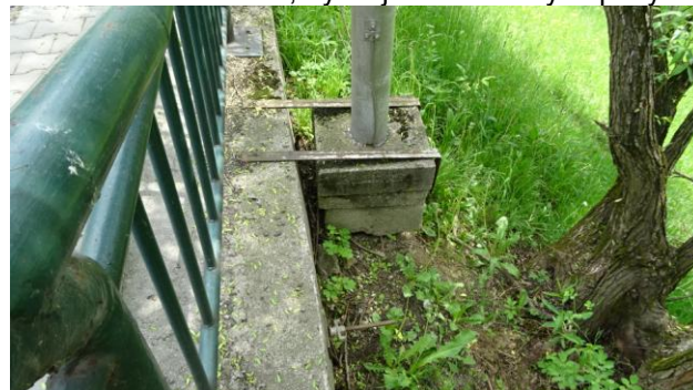
Pohled na základ stožáru – viz foto výše. Zajištění základu stožáru proti naklání.
