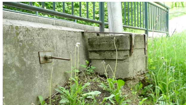
Detail betonového základu stožáru VO za OP4 vpravo. Základ se naklání, byl zajištěn ocelovými pásy.
