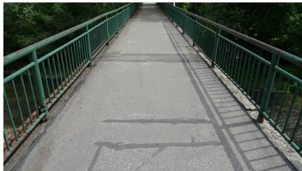
Trhlina v mostovce z LA – zapraveny asfaltovou zálivkou.
