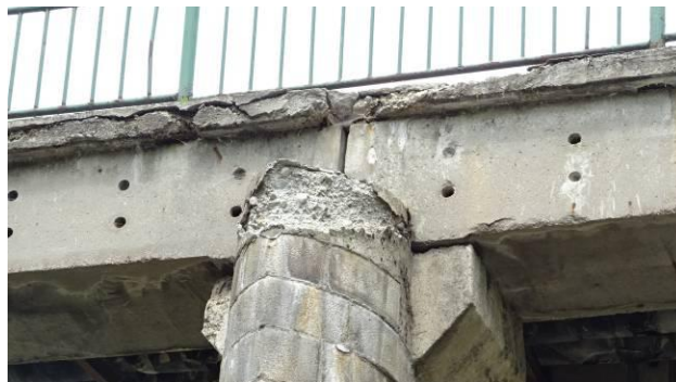
Návodní zhlaví podpěry P2. Rozpad betonu.
