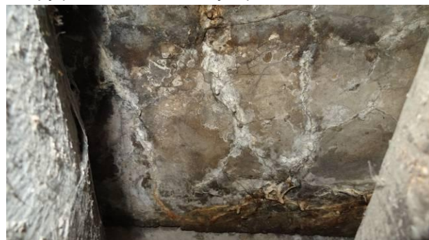
Ditto foto vedle. Stejně závady. Trhliny v betonu mostovky, zatékání, inkrustace.
