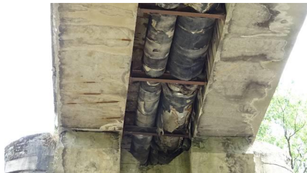
Podhled NK v poli 1 před podpěrou P2. Stopy po zatékání na boky a podhled nosníku MPD.
