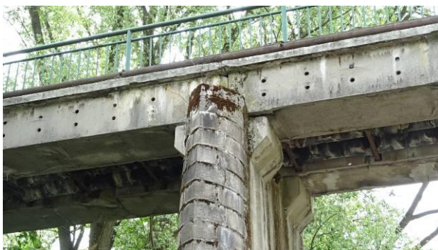
Povodňové zhlaví podpěry P3
