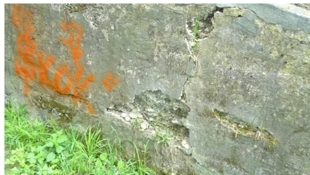
Detail foto výše – nesoudržný beton, tvorba kaverny.
