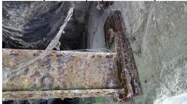
OPP- příčníky jsou zavěšeny na čepu, který je vložený do otvoru ve stěně nosníku MPD.
