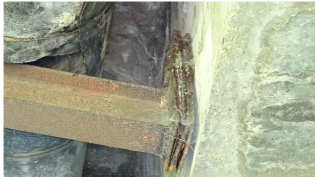
OPP – závěsný čep je s příčníkem spojen ocelovou deskou provedenou z několika vrstev tenkých plechů
