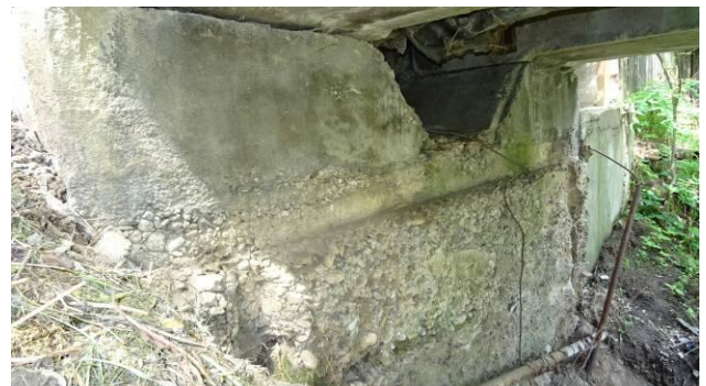
Pohled na OP1. Ve spodní části je sesutý svah před opěrou, obnažený beton je hrubý, nerovný.
