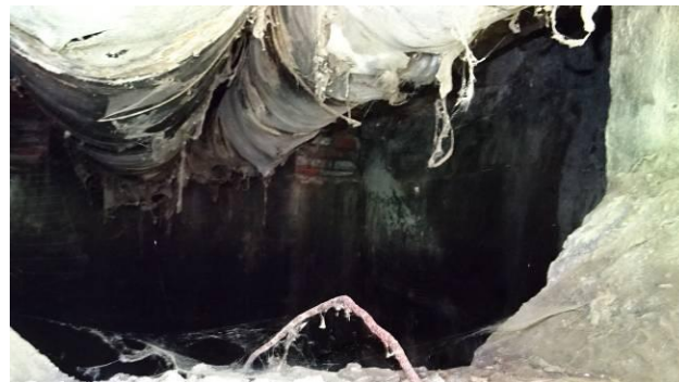
Komora OP1 – levá stěna. Průsaky a výluhy stěnou křídla K1L.
