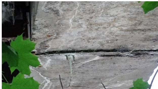
Detail příčné spáry levého nosníku MPD v poli 3. Příčnou spárou zatéká, tvoří se krápníky. Může být oslabena předpínací nosná výztuž.
