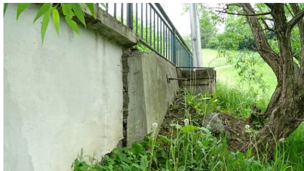
Opěrná zeď (OZ) navazující na křídlo K4P. OZ se vyklonila, byla zajištěna ocelovým táhlem.
