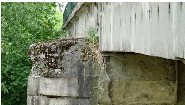
Povodňové zhlaví podpěry P2. Rozpad betonu zhlaví.
