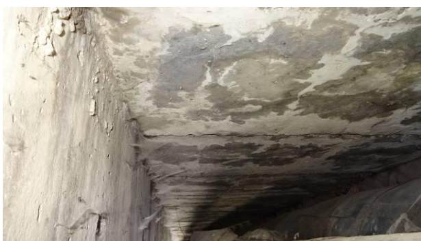
Podhled mostovky – betonové prefa desky v poli 1.
