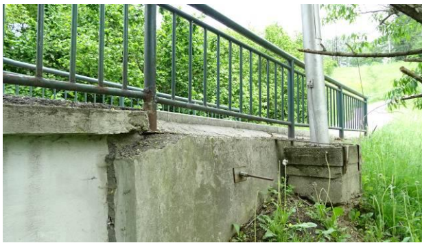
Opěrná zeď (OZ) navazující na křídlo K4P. OZ se vyklonila, byla zajištěna ocelovým táhlem. V pozadí betonový základ stožáru VO, které je také nakloně.
