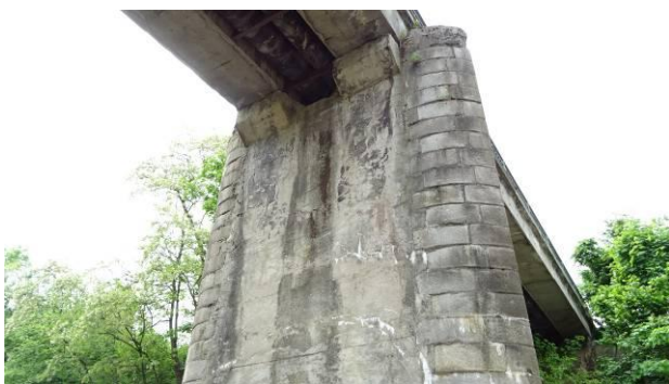
Podpěra P3 – horní část. Průsaky v dřívku pilíře.
