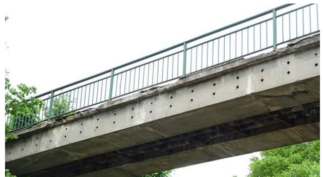
Nosná konstrukce – nosníky MPD v poli 1.
