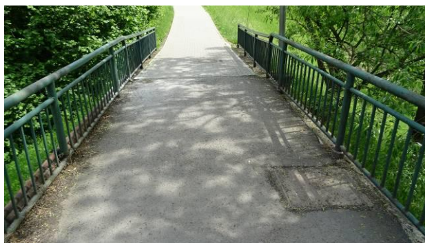
Mostovka nad OP4 – zapravený otvor do komory opěry OP4.
