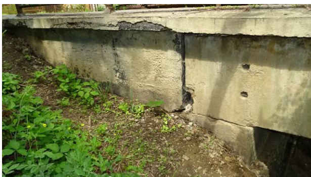
Opěra 1 – křídlo K1P. Uložení nosníků bezložiskové.
