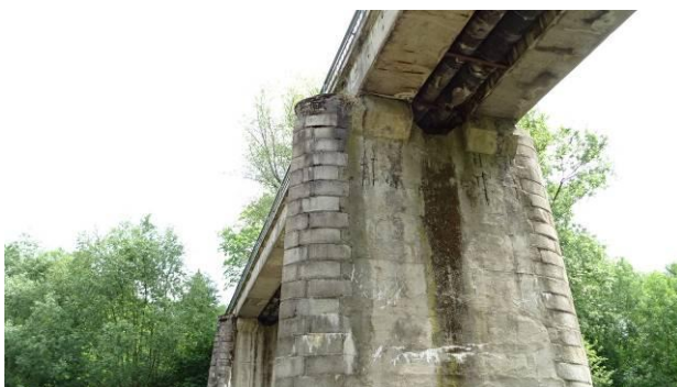
Podpěra P2 – úložné konzoly.
