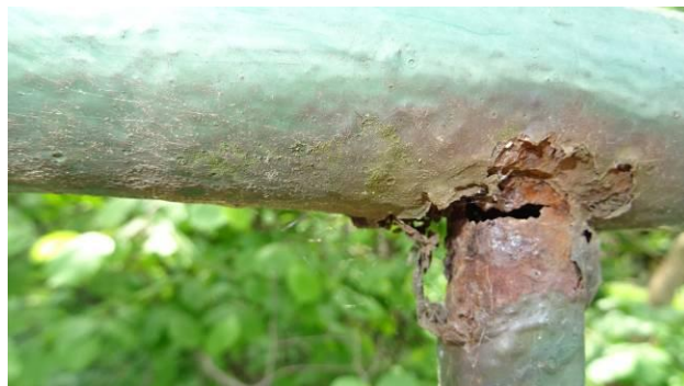
Detail foto vedle – prokorodovaná trubka výplně.
