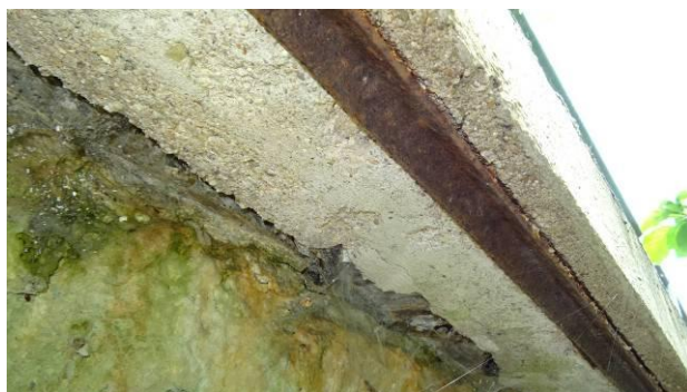
Podhled římsy nad OP1 vpravo. V okapním nose byl ponechán bednicí ocelový úhelník – koroduje.
