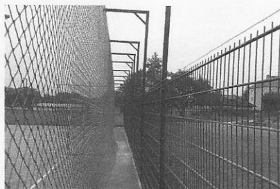
SPRÁVNÉ provedení ráků s „U“ profilem a lankem proti zachytávání předvěšené sítě
