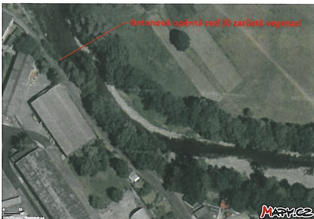
Fotomapa zájmového území z r.2006. Betonová opěrná zeď na MK 74c před dřevomodelárnou již zarůstá vegetací.
