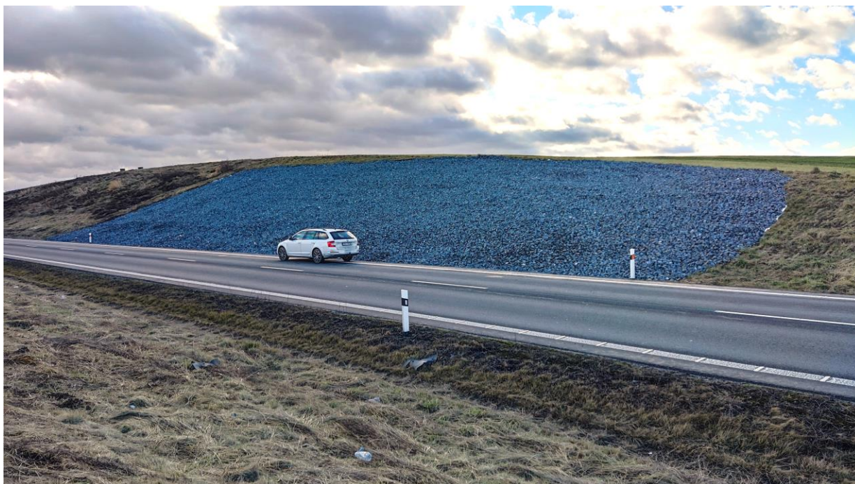
Obr. 4 Snímek z realizace sanace sesuvu na přivaděči u Studénky.
