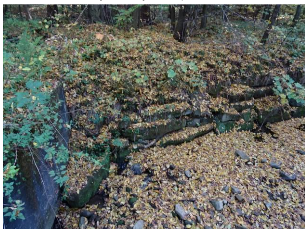
Opevnění pravého břehu před mostem.
