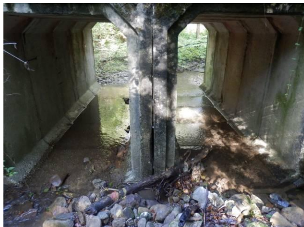
Střední podpěra – spodní část. Spára mezi prefabrikáty není překrytá..
