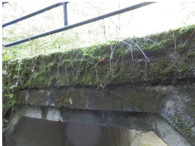
Fasáda levé krajní přičle. Beton je celý porostlý mechy.
