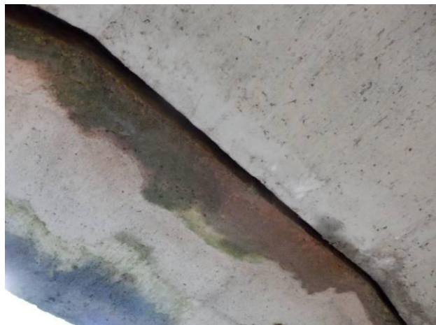
Pole 1 zatékání ve spárách.
