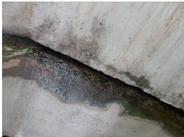
Pole 1 zatékání ve spárách.
