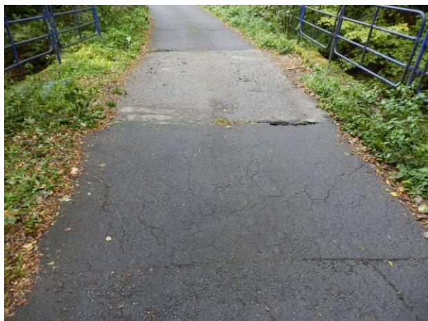
Pohled na vozovku před mostem. Trhliny AB krytu na předmostí.
