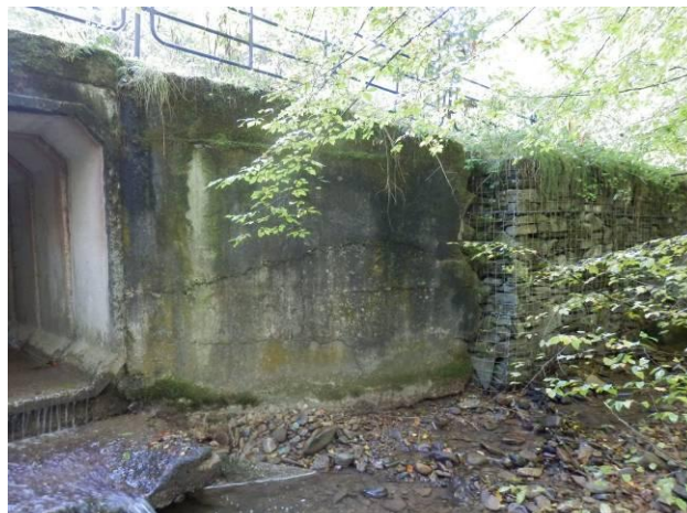
Pravé křídlo OP2. Na křídlo navazuje opěrná zeď z gabionů.
