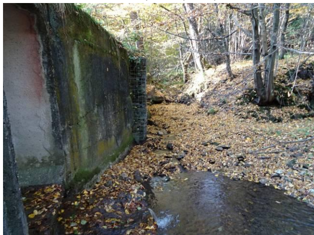
Gabionová stěna za mostem vpravo. Gabion je nakloněný.
