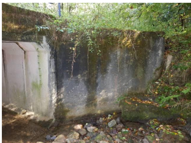
Levé křídlo OP1. Beton křídla je mokrý, horní část je porostlá vegetací.
