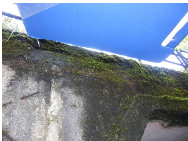
Střední podpěra – horní část. Beton je porostlý mechy.
