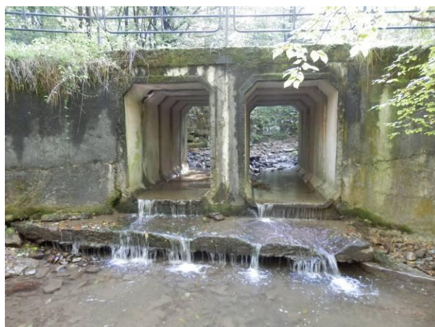
Pohled na most zprava od výtoku. Vodní stupeň je podezřelý.
