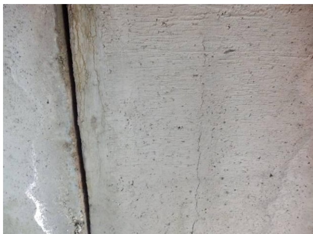
Svislé trhliny v rámových stojkách.
