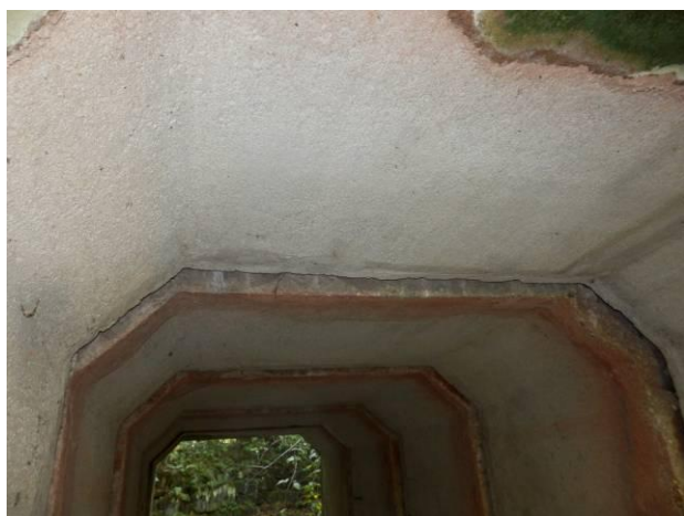
Příčel NK v poli 2. Výškové nerovnosti v podhledu příčlí.
