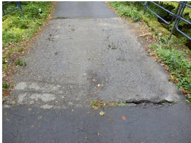
Detail betonové vozovky na mostě. Prosedlá vozovka vpravo před prefa rámem.
