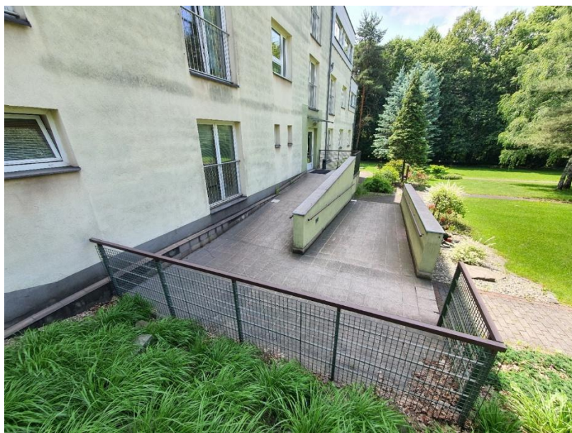
1. Fotodokumentace venkovní rampy – stávající stav
