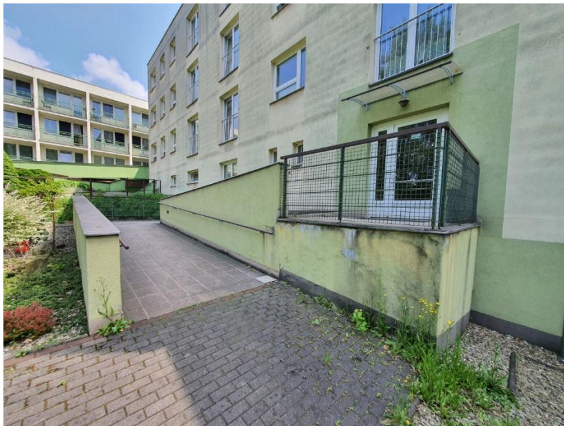
2. Fotodokumentace venkovní rampy – stávající stav
