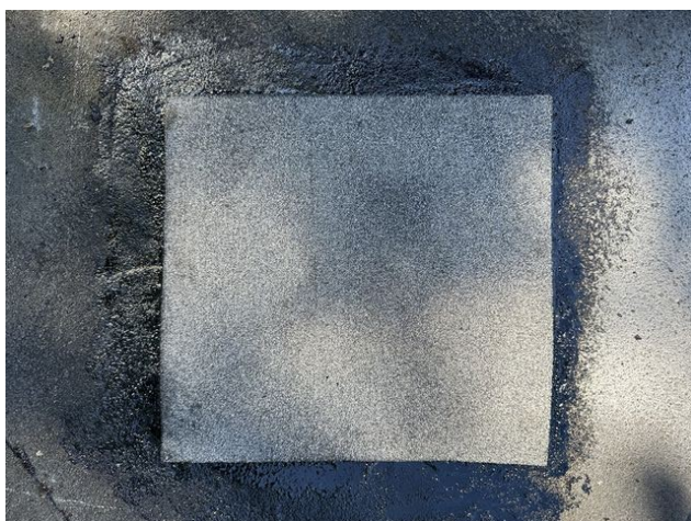
foto /97/ Pohled na zapravené místo sondy S7 – spodní pás
