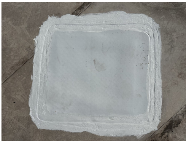
foto /134/ Pohled na zapravené místo sondy S14
