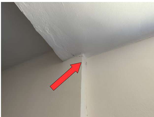
foto /93/ Pohled na svislou trhlinu v místě rozhraní budov G1b a G1c
