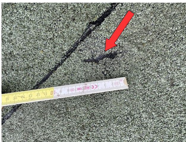
foto /34/ Pohled na lokální poškození ochranné vrstvy asfaltových pásů
