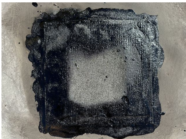
foto /121/ Pohled na zapravené místo sondy S10 – spodní pás
