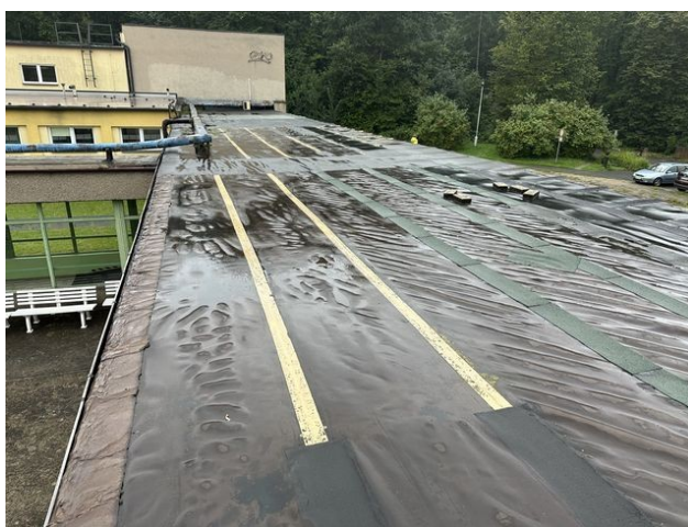
foto /42/ Pohled na viditelné zvlnění pryžové fólie v celé ploše střechy
