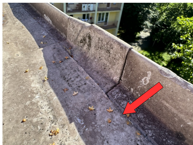
foto /143/ Ukončení fólie na poplastované závětrné liště, spoj proti vodě
