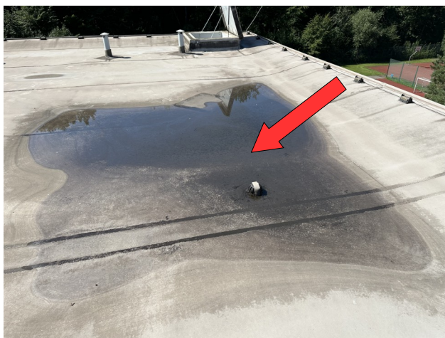
foto /142/ Pohled na louže na povrchu povlakové hydroizolace v blízkosti vtoku
