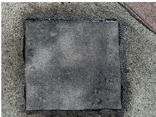
foto /78/ Pohled na zapravené místo sondy S13 – spodní pás
