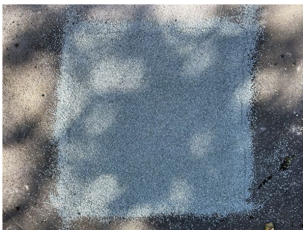
foto /98/ Pohled na zapravené místo sondy S7 – horní pás
