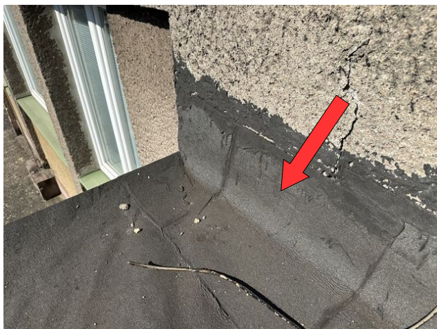
foto /109/ Pohled na opravy pryžové fólie asfaltovými pásy v místě návaznosti na objekt E
