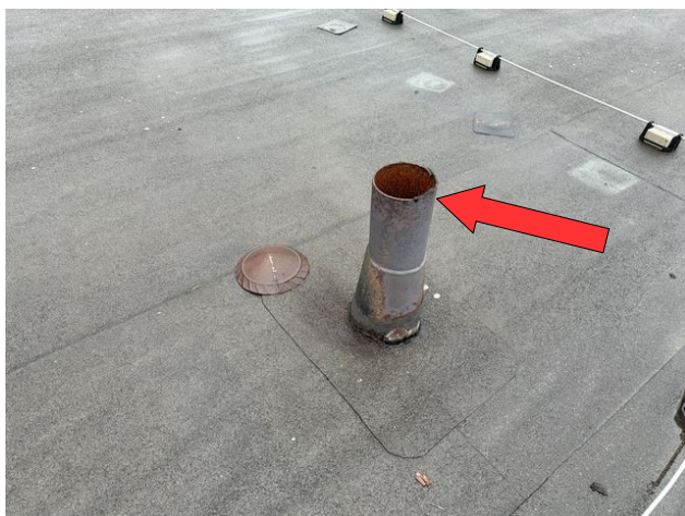
foto /25/ Pohled na absenci dešťové krytky prostupu
