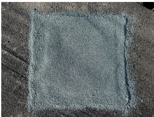
foto /9/ Pohled na zapravené místo sondy S1 – horní pás
