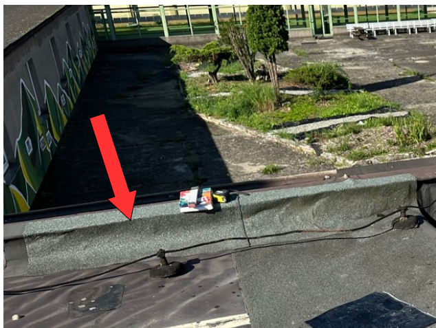
foto /123/ Pohled na lokální opravy asfaltovými pásy
