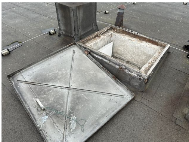
foto /23/ Pohled na víko střešního výlezu, upadnutí jedné strany kování víka
