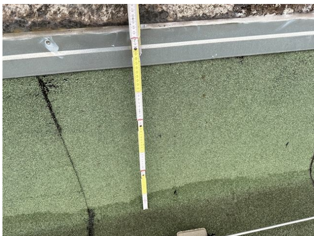
foto /37/ Pohled na způsob vytažení a ukončení povlakové hydroizolace na navazující budovu
