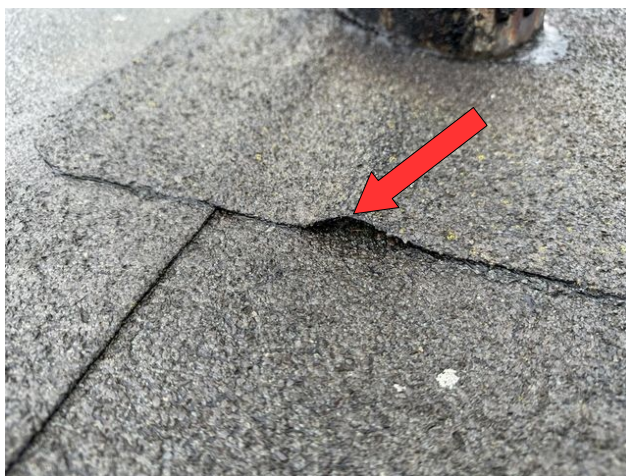
foto /16/ Pohled na lokální netěsnosti spojů povlakové hydroizolace
