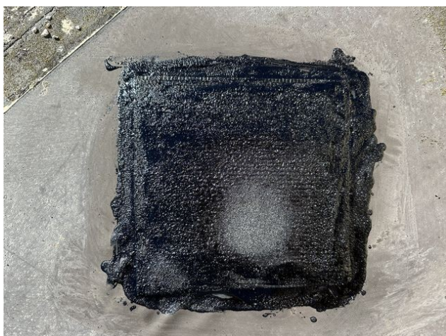
foto /74/ Pohled na zapravené místo sondy S12 – samolepící spodní pás
