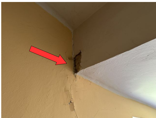
foto /90/ Pohled na opadanou omítku v místě trhliny stropní konstrukce
