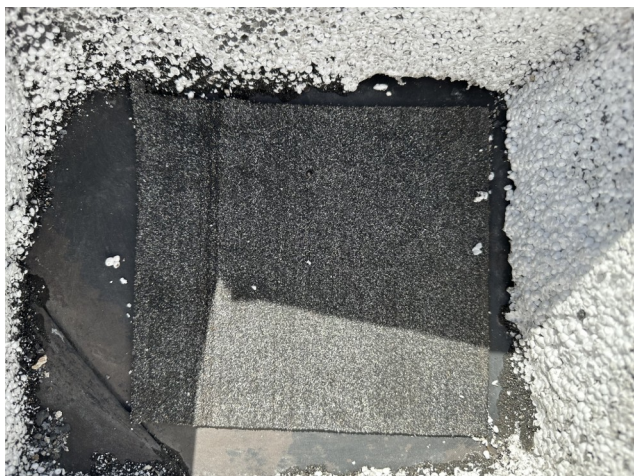
foto /133/ Pohled na zapravení původní vrstvy hydroizolace samolepícím asfaltovým pásem
