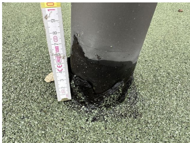
foto /36/ Pohled na nedostatečné vytažení (min. 150 mm) povlakové hydroizolace na kruhový prvek
