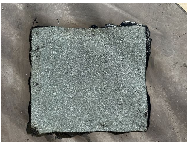
foto /71/ Pohled na zapravené místo sondy S11 – horní pás
