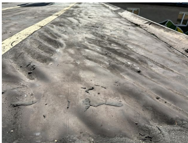
foto /108/ Pohled na zvlnění pryžové hydroizolace
