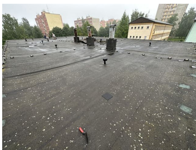
foto /18/ Pohled na tvorbu lišejníků na povrchu povlakové hydroizolace
