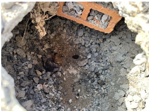
foto /30/ Pohled do místa provedené sondy S3, cihla dvouděrová spojující větrací otvory na fasádě
