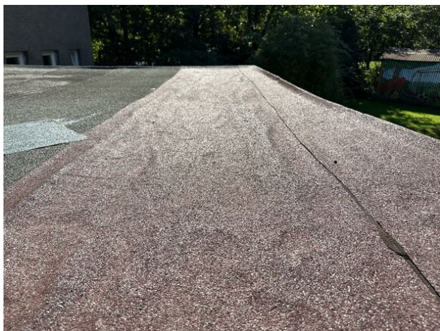
foto /80/ Pohled na zvlnění povlakové střechy z asfaltových pásů (střecha G1a)
