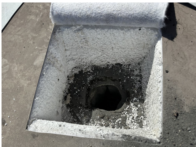
foto /131/ Pohled na provedenou sondu S14 přes dodatečné zateplení střechy
