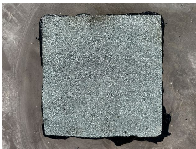
foto /53/ Pohled na zapravené místo sondy S4 – horní pás
