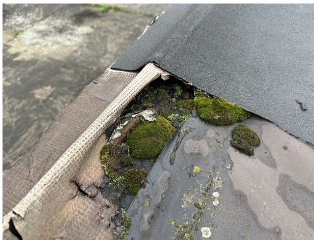
foto /59/ Pohled na opravení závětrné lišty povlakovou hydroizolací
