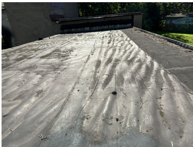
foto /81/ Pohled na viditelné zvlnění pryžové fólie v celé ploše střechy (uvedena střecha G1b)
