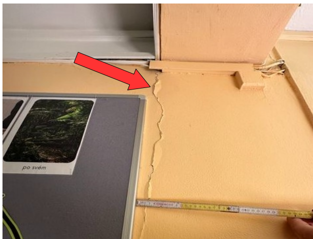
foto /112/ Detailnější pohled na trhlinu
