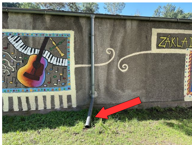
foto /87/ Pohled na odvodnění střechy na přilehlý terén (střecha G1b)
