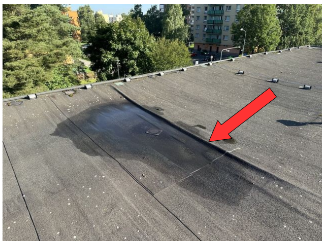
foto /15/ Pohled na zvlnění ve vrstvě povlakové hydroizolace
