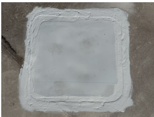
foto /140/ Pohled na zapravené místo sondy S15
