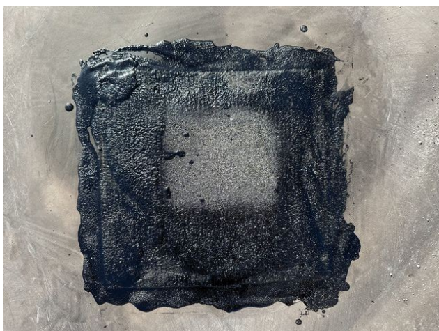
foto /101/ Pohled na zapravené místo sondy S8 – samolepící spodní pás
