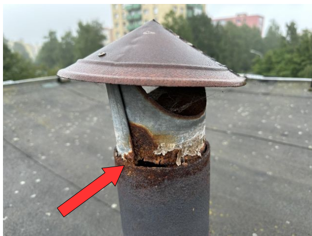
foto /24/ Pohled na degradaci jednoho z prostupů střešním pláštěm
