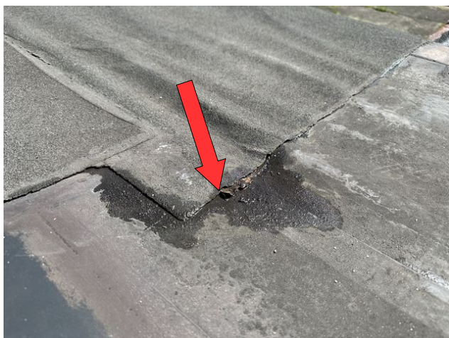
foto /43/ Pohled na vytékající vodu z pod lokální opravy povlakové hydroizolace
