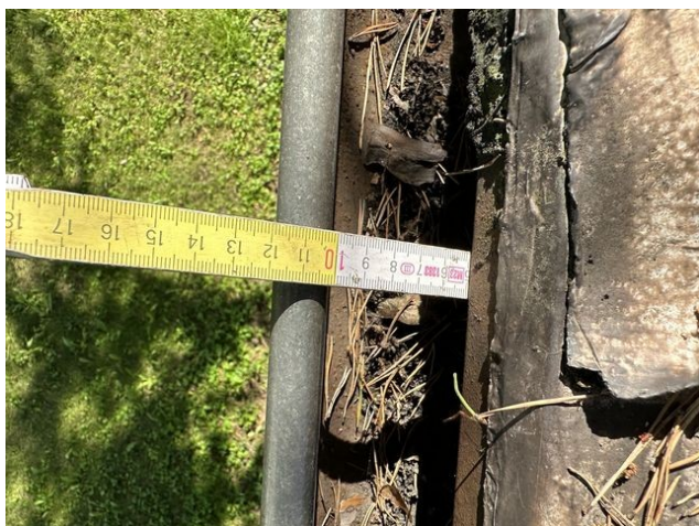
foto /86/ Pohled na spadané biologické nečistoty v podokapním žlabu (střecha G1b)
