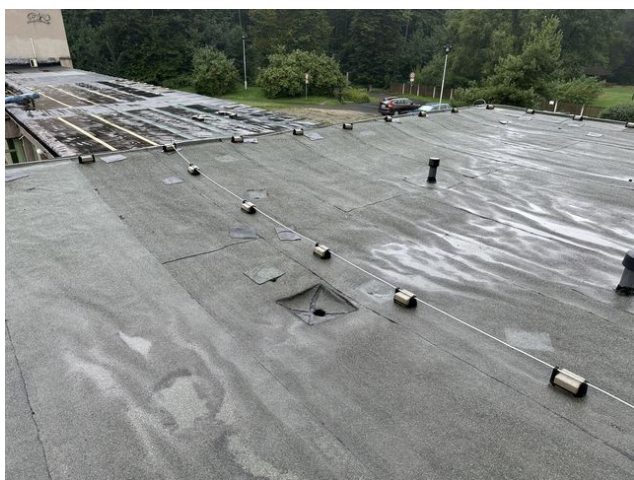
foto /33/ Pohled na zvlnění povlakové hydroizolace
