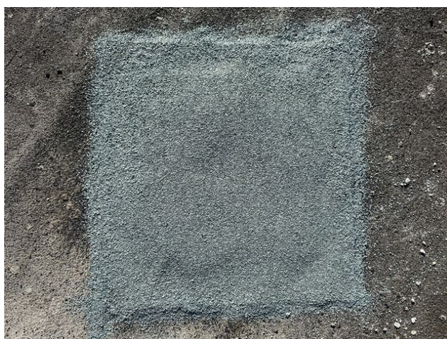
foto /14/ Pohled na zapravené místo sondy S2 – horní pás
