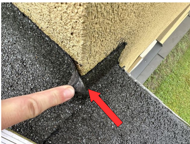
foto /85/ Netěsné opracování povlakovou hydroizolací
