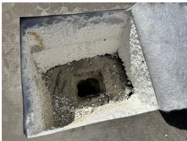
foto /137/ Pohled na provedenou sondu S15 přes dodatečné zateplení střechy
