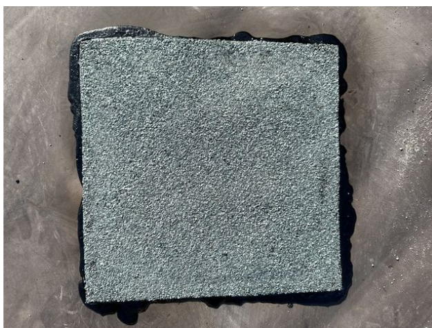
foto /102/ Pohled na zapravené místo sondy S8 – horní pás
