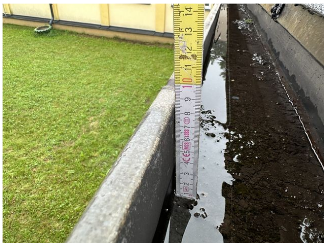
foto /47/ Pohled na hranatý podokapní žlab, stojící voda ve žlabu
