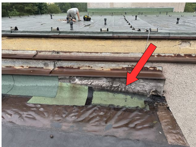
foto /45/ Pohled na chybějící část opravy atiky vytažením hydroizolace
