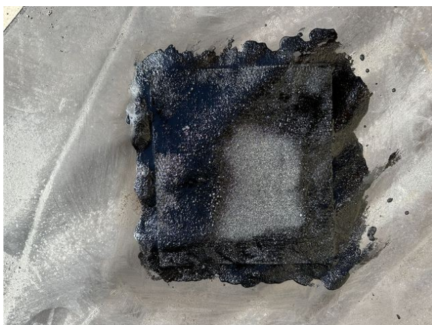
foto /70/ Pohled na zapravené místo sondy S11 – samolepící spodní pás
