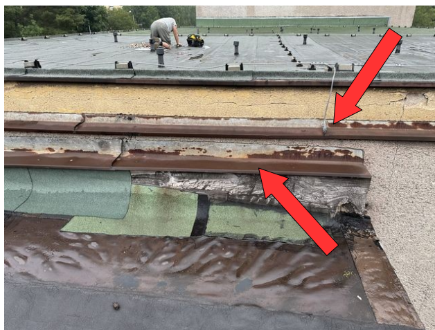
foto /46/ Pohled na patrnou korozi oplechování atiky
