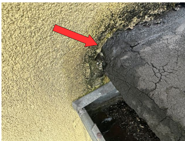
foto /44/ Pohled na poškození fasády vlivem absence opracování hydroizolací
