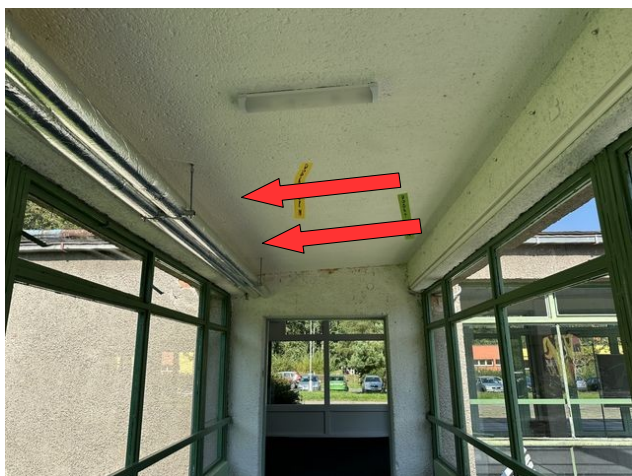
foto /62/ Pohled na spodní líc nosné konstrukce, prefa ŽB panely ve spádu (šipkami naznačen směr spádu)
