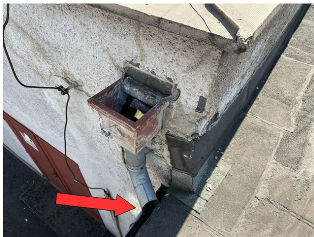
foto /127/ Pohled na svod vody do nižšího podokapního žlabu sousední střechy
