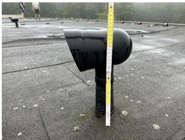
foto /26/ Pohled na komínek vedoucí pouze do skladby střešního pláště
