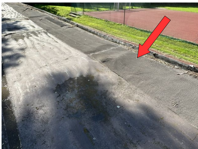
foto /82/ Pohled na kontinuálně navazující opravu povlakové hydroizolace v místě závětrné lišty (uvedena střecha G1c)
