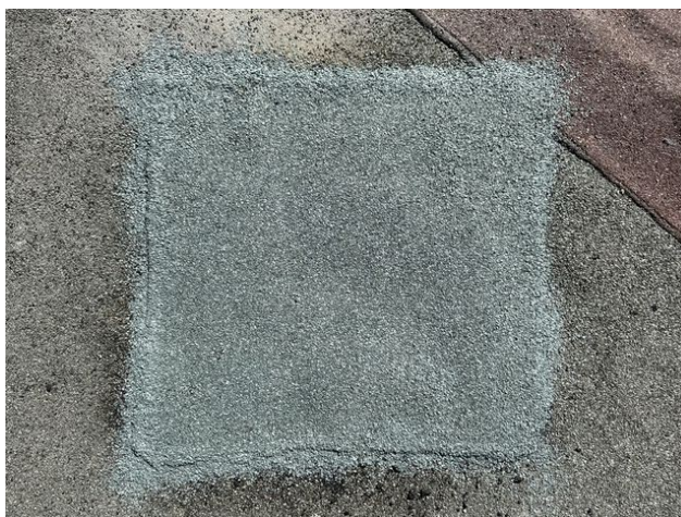
foto /79/ Pohled na zapravené místo sondy S13 – horní pás
