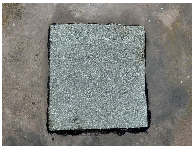
foto /67/ Pohled na zapravené místo sondy S6 – horní pás
