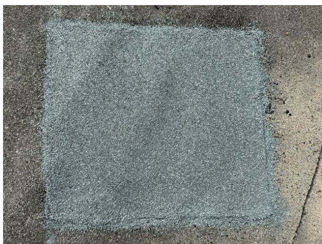
foto /32/ Pohled na zapravené místo sondy S3 – horní pás
