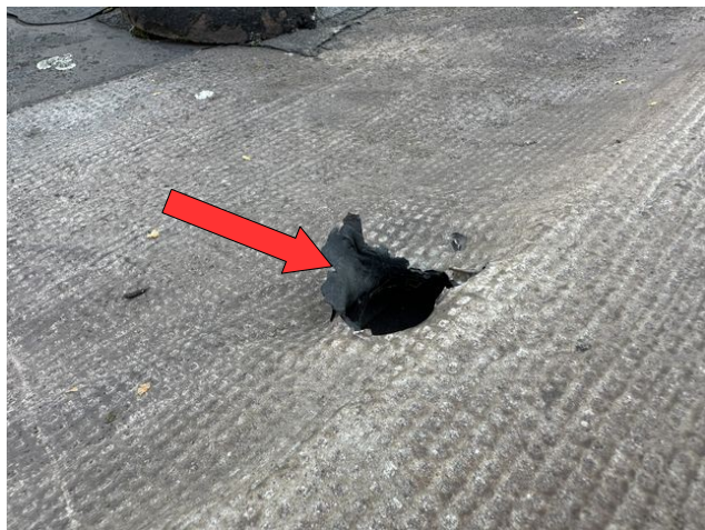
foto /125/ Pohled na netěsnosti opravované povlakové hydroizolace
