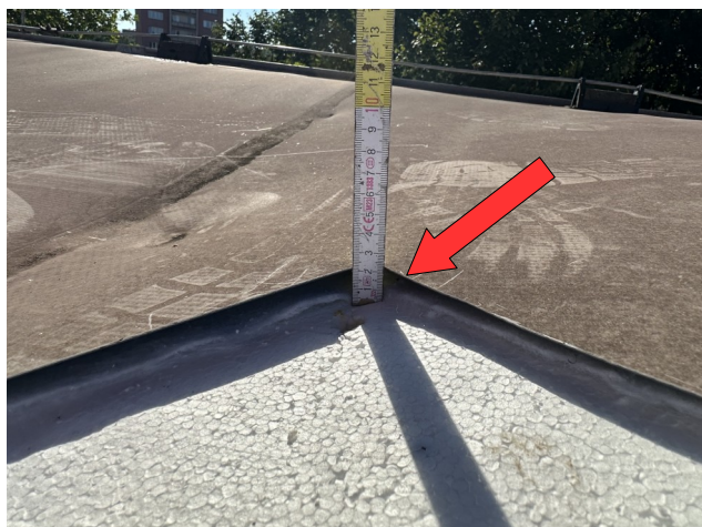
foto /141/ Pohled na napnutou povlakovou hydroizolaci
