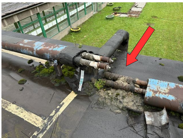
foto /48/ Pohled na místo porušení teplovodu
