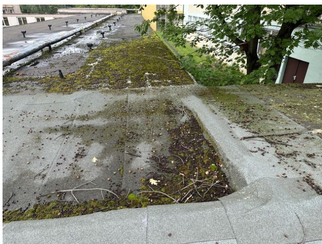
foto /103/ Pohled na růst mechů a znečištění povlakové hydroizolace
