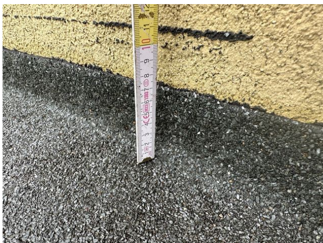
foto /84/ Pohled na nedostatečné vytažení povlakové hydroizolace, hydroizolace bez řádného ukončení
