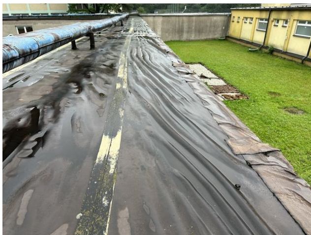
foto /58/ Pohled na výrazné zvlnění povlakové hydroizolace z pryžové fólie
