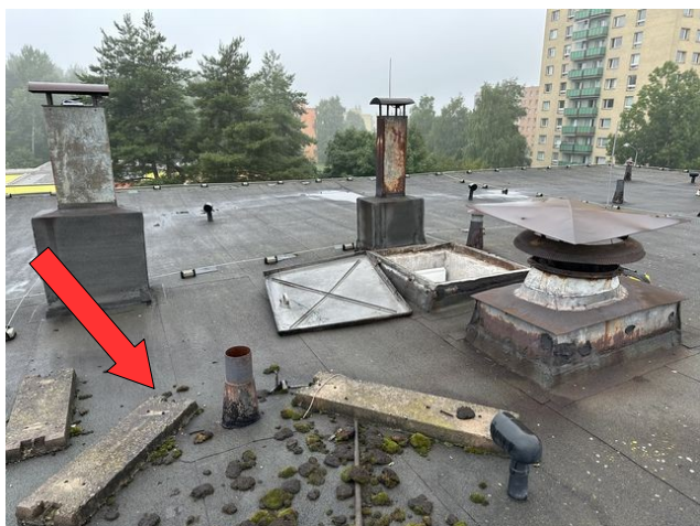
foto /19/ Pohled na růst mechů v oblasti cizích těles na povrchu střešního pláště
