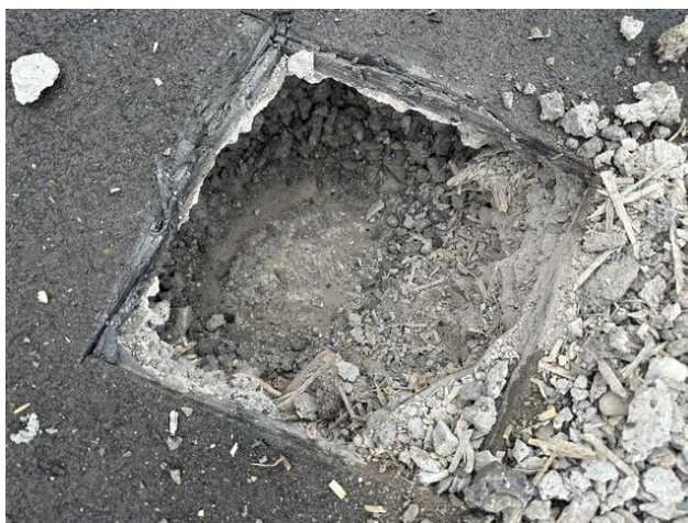
foto /7/ Pohled do místa provedené sondy S1
