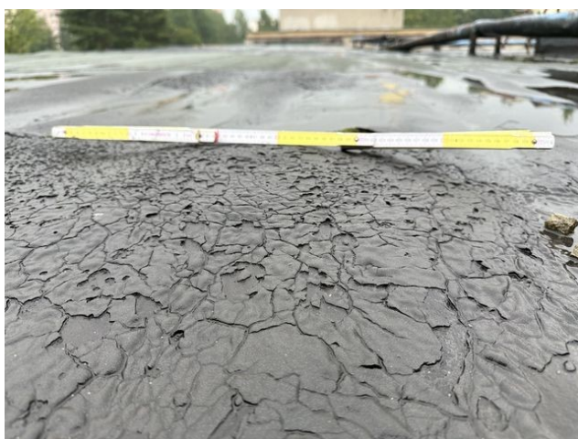
foto /41/ Pohled na puchýř povlakové hydroizolace, výrazná degradace povlakové hydroizolace
