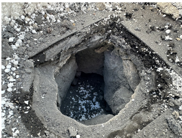
foto /132/ Pohled na provedenou sondu S14 – původní skladba, viditelná vlhkost pod původní hydroizolací na povrchu betonového potěru
