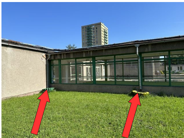
foto /61/ Pohled na místa fasádních svodů, voda sváděna na povrch dvorku
