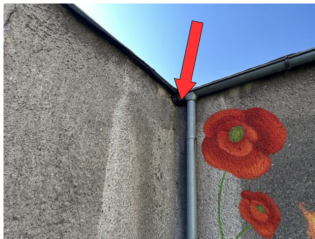
foto /89/ Pohled na stopy po zatékání v místě odvodu vody z úžlabí střechy G1a
