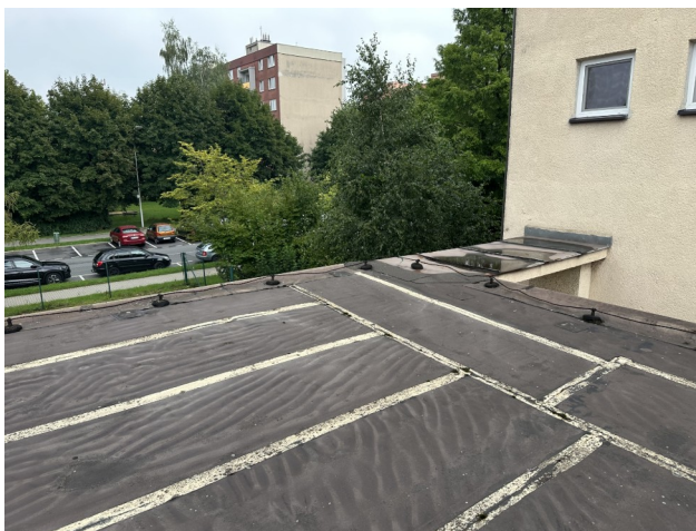
foto /124/ Pohled na zvlněnou povlakovou hydroizolaci
