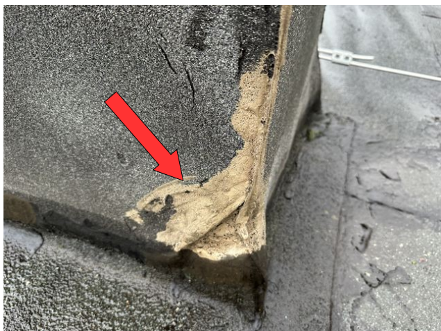
foto /21/ Pohled na lokální opravy povlakové hydroizolace tmelem
