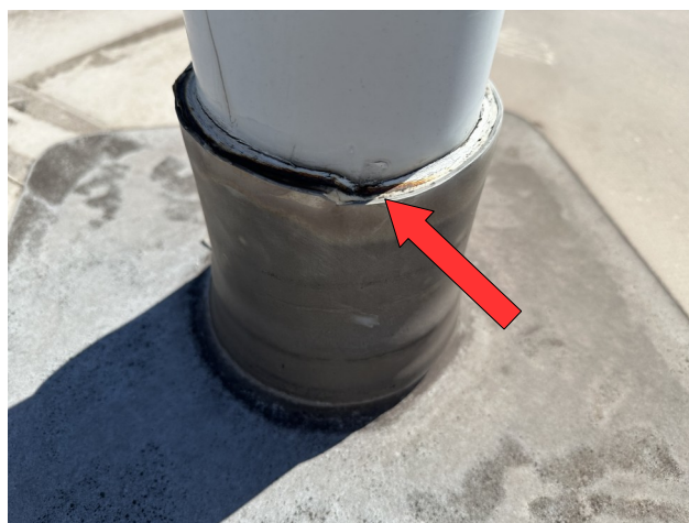
foto /144/ Pohled na vytažení hydroizolace a její podtmelení, absence stahovací nerezové objímky
