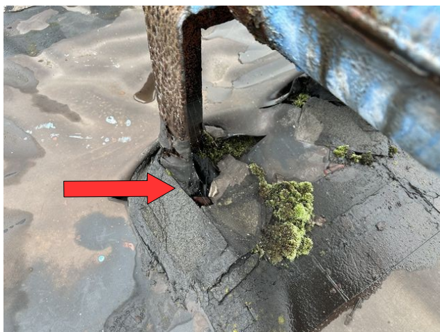
foto /60/ Pohled na netěsné opracování kotevních bodů teplovodu
