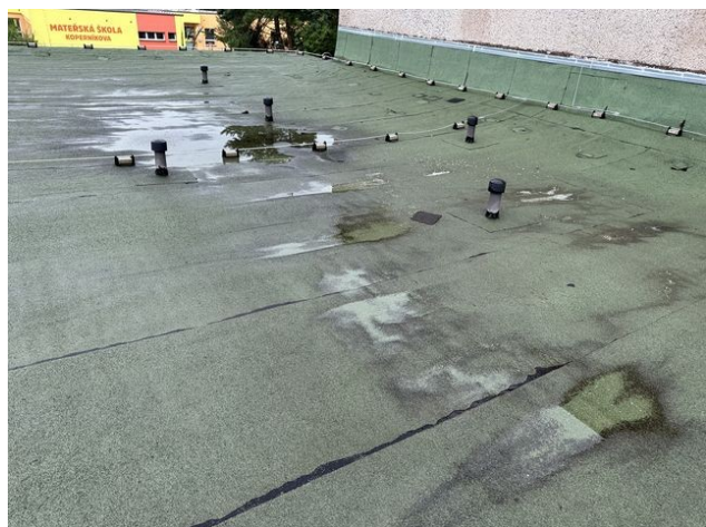
foto /35/ Pohled na louže na povrchu povlakové hydroizolace
