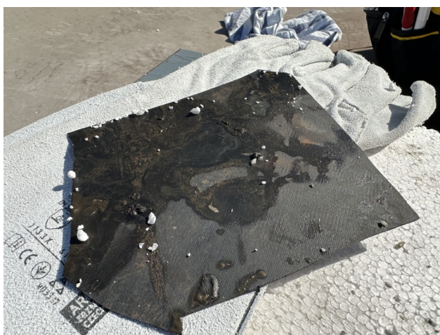
foto /130/ Nalezená vlhkost na povrchu původní hydroizolace ve styku s tepelným izolantem
