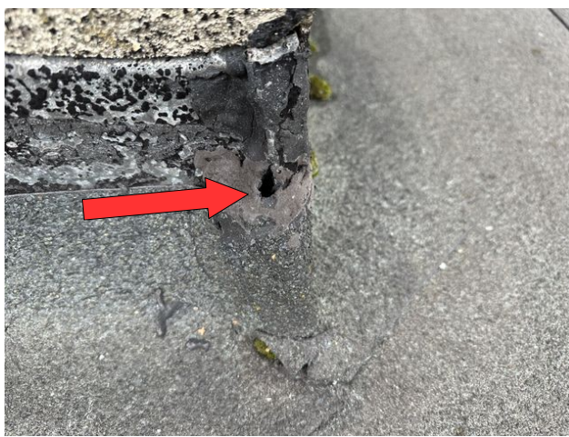
foto /104/ Pohled na netěsnosti opravení povlakové hydroizolace
