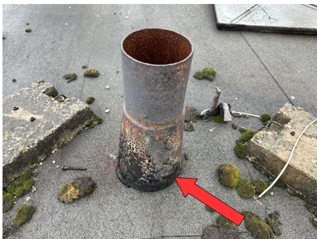
foto /20/ Pohled na absenci opravy průstupu střešním pláštěm povlakovou hydroizolací
