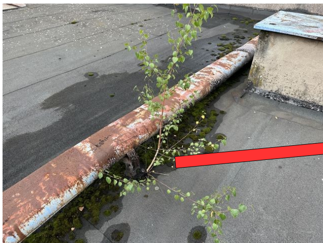
foto /105/ Pohled na rostoucí vegetaci v místě prostupu podpory teplovodu
