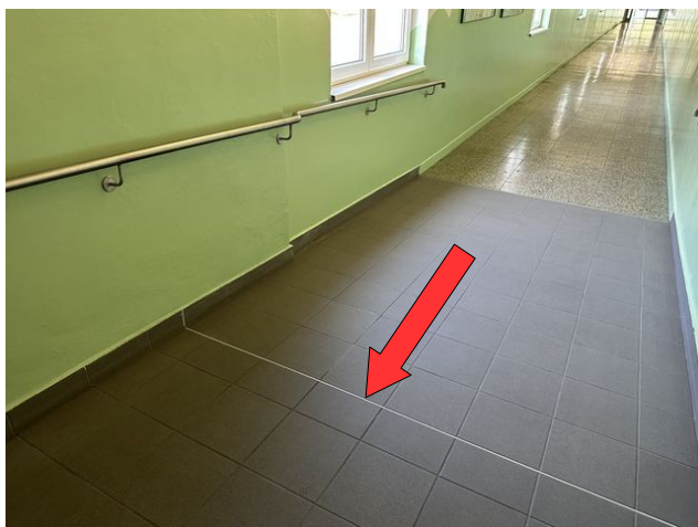
foto /92/ Pohled na místo výměny dlažby rampy v místě rozhraní budov G1b a G1c
