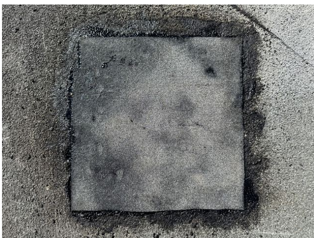
foto /117/ Pohled na zapravené místo sondy S9 – spodní pás
