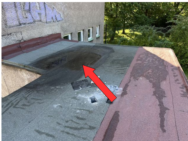
foto /88/ Pohled na způsob odvodnění střechy G1a, tvorba louží, nedostatečný spád úžlabí
