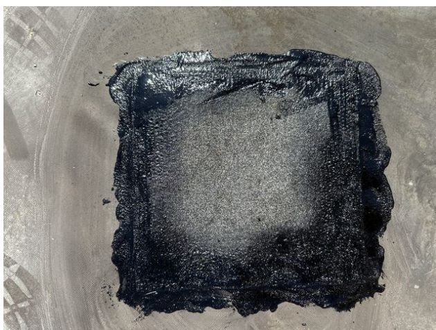
foto /52/ Pohled na zapravené místo sondy S4 – samolepící spodní pás
