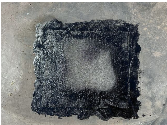
foto /66/ Pohled na zapravené místo sondy S6 – samolepící spodní pás
