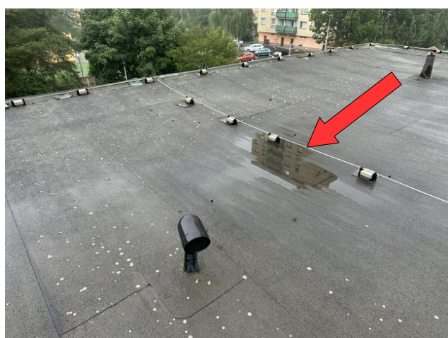
foto /17/ Pohled na louže na povrchu povlakové hydroizolace
