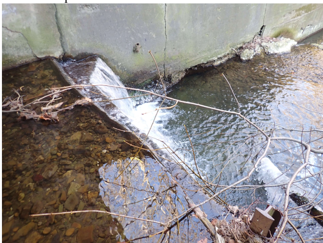
Podemleté opevnění břehu křídla K1L
