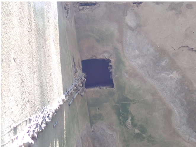
Podhled Nk u odvodňovače na výtoku
