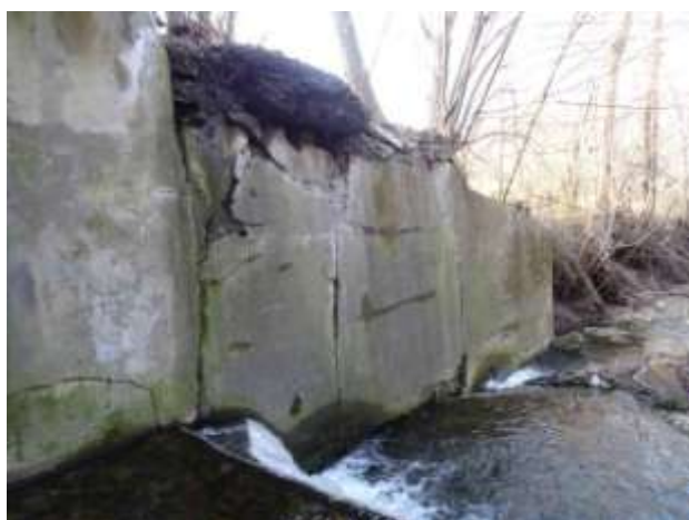
Opěrná zeď vedle OP1 vlevo na výtoku. Původně tato konstrukce sloužila jako mostní opěra původního mostu.
