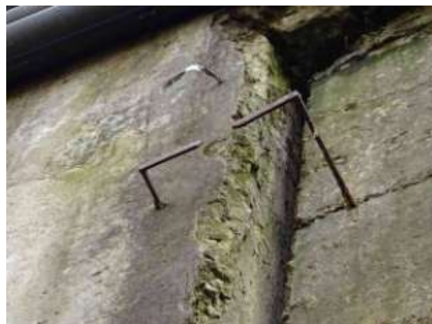
Detail foto vedle. Od poslední HP bylo osazeno měřící zařízení.
