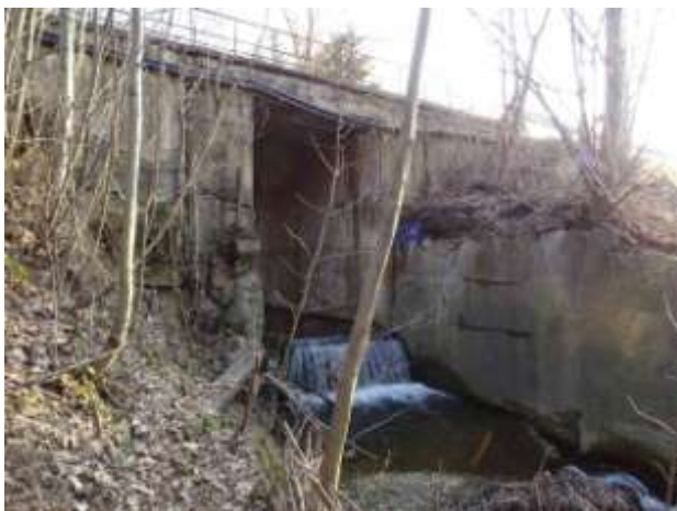
Pohled na most zleva od výtoku – OP1 je vpravo.
