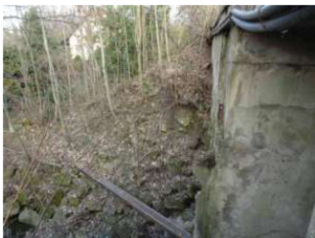
Naklonění křídla K2L a svah před křídlem.
