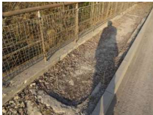
Levý chodník nad NK mostu.
