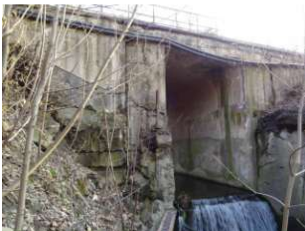
Celkový pohled na křídlo K2L.
