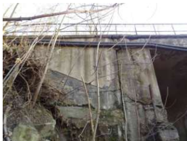
Horní část křídla K2L. Vedle OP2 je ponechán sloupek zábradlí původního mostu.
