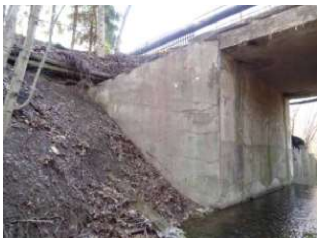
Křídlo K1P na vtoku. Svah kolem křídla je strmý a sesouvá se. Horní část svahu zajišťují dřevěné kulatiny. Četné trhliny v křídle.
