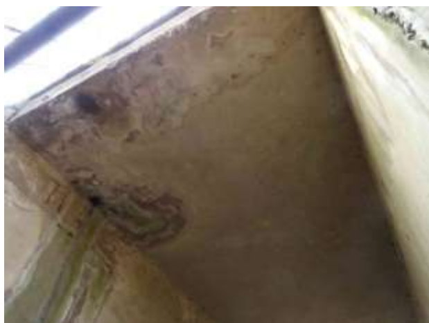
Podhled NK vpravo na vtoku.
