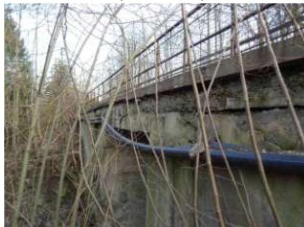
Levá fasáda NK - pohled od křídla K1L.
