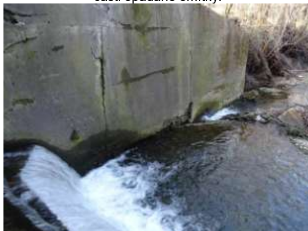
Opěrná zeď vedle OP1 vlevo na výtoku – spodní část pod vodním stupněm.
