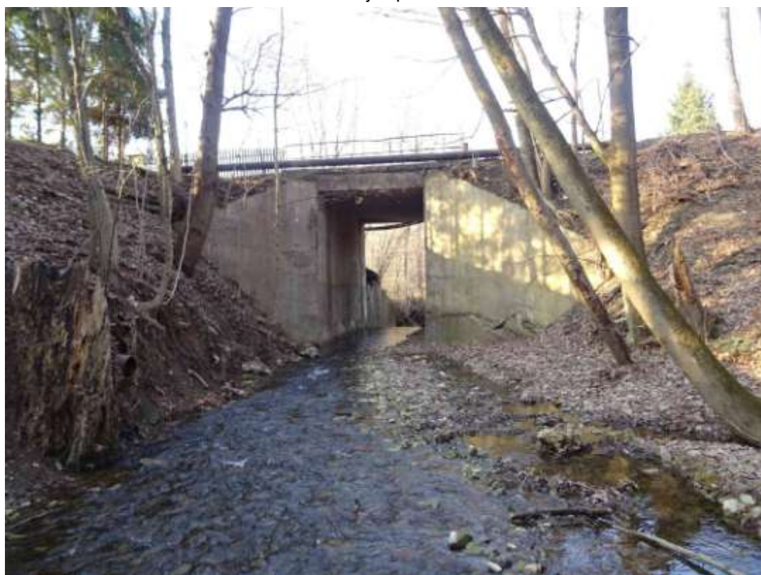
Pohled na most zprava od vtoku. Opěra 1 (OP1) je vlevo.
