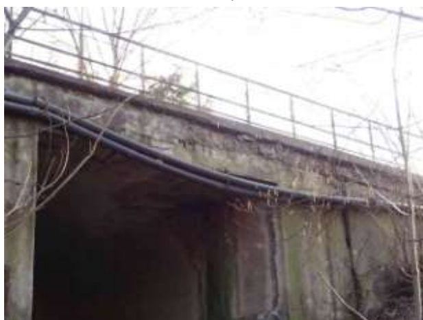
Levá fasáda – uvolněná a prověšená chránička.
