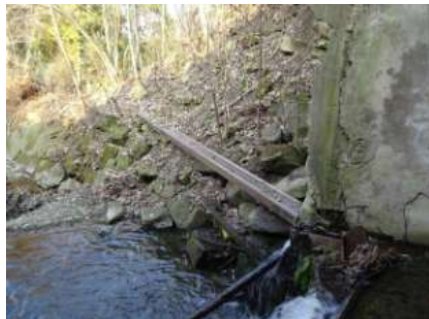
Pohled z mostního otvoru na výtoku na pravý břeh
