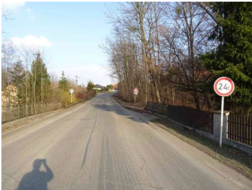
Pohled na most ve směru staničení k nemocnici Podlesí. Vtok je vpravo.
