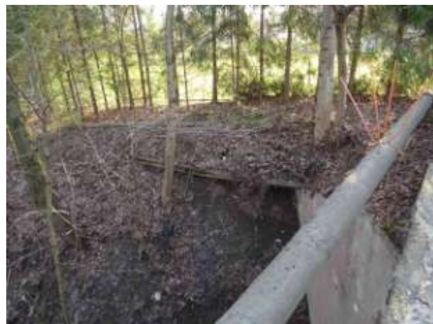
Horní část svahu vedle křídla K1P zajišťují dřevěné kulatiny.
