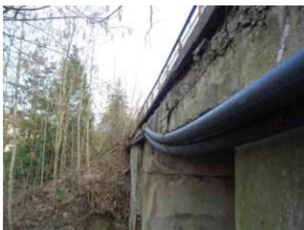
Levá fasáda NK - pohled od křídla K1L.
