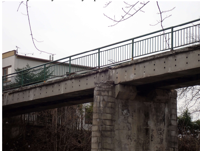
PO2 s vydroleným úložným prahem
