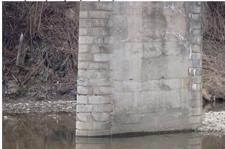
PO2 s vydroleným úložným prahem
