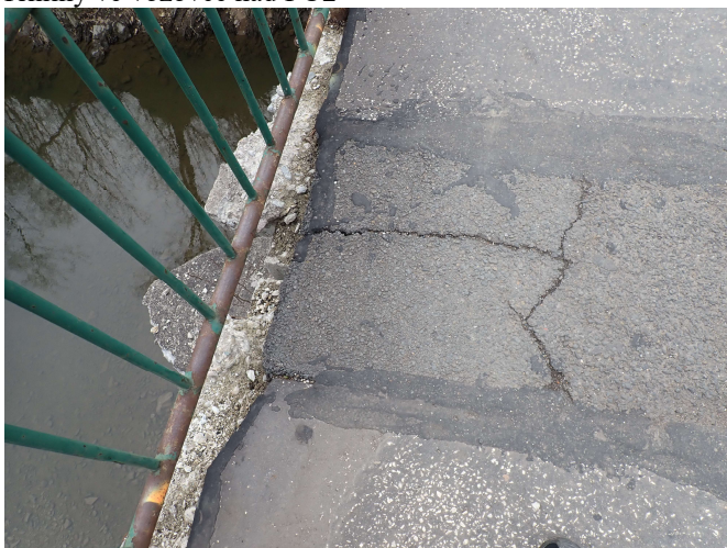
Zábradlí – odrezlá svislá výplň- typický stav
