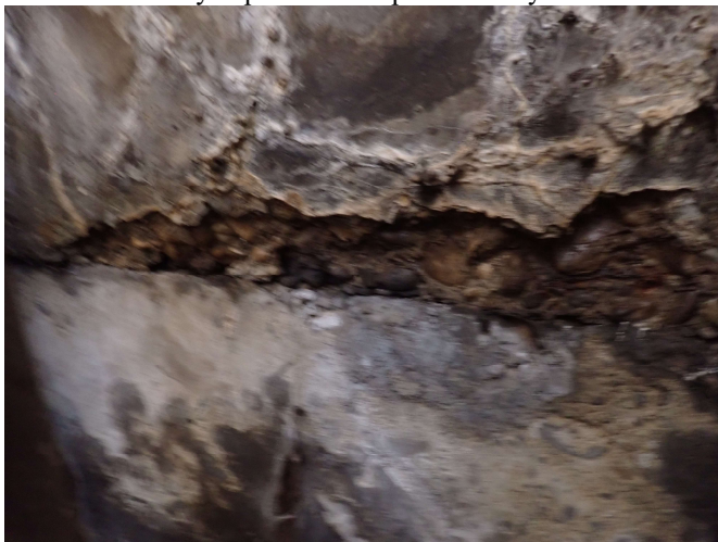
Podhled betonových panelů záklopů mostovky
