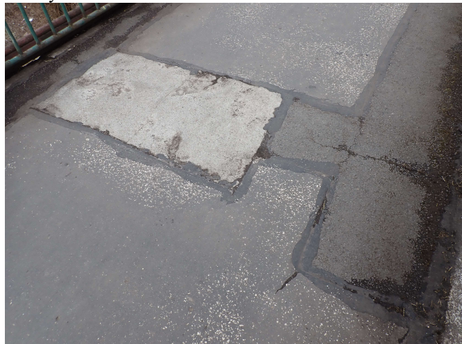
Zatékání na pohledu Nk
