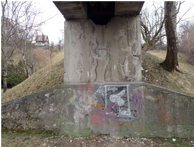
PO2 s vydroleným úložným prahem
