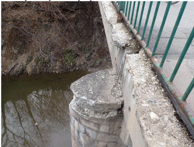
PO2 s vydroleným úložným prahem
