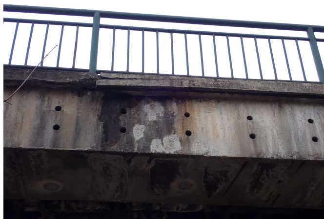
Rozpadávající se římsa v poli 3
