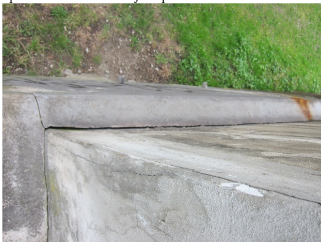
Spára mezi OP4 a navazující opěrnou stěnou
