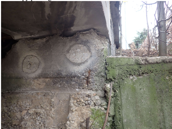
Podhled betonových panelů záklopů mostovky
