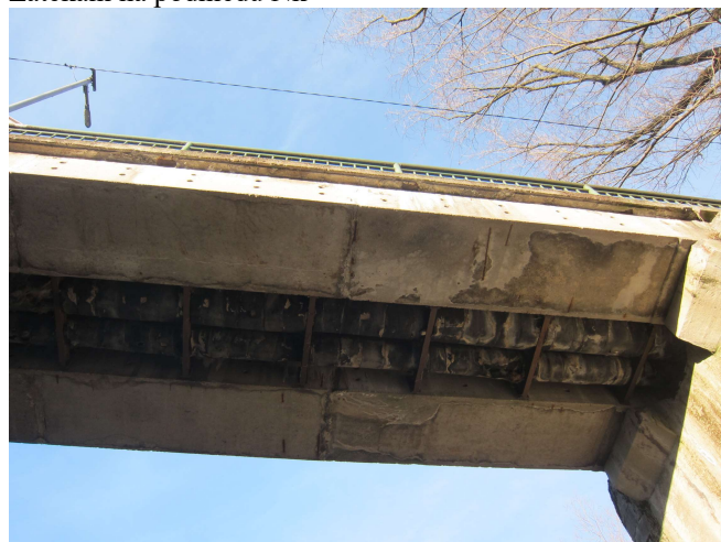
Rozpadávající se římsa v poli 3
