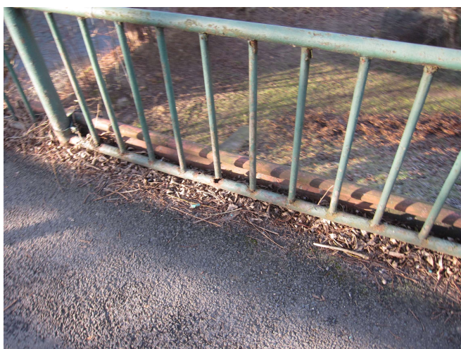
Zábradlí – odrezlá svislá výplň- typický stav
