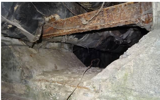
Průhled dírkem do komory OP1
