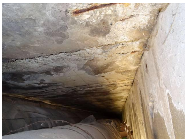
Betonové prefabrikované desky mostovky.
