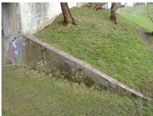
Svahové křídlo před OP4 vpravo.
