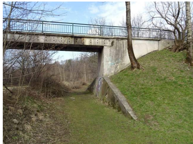
Pole 3 – pravý břeh – opěra OP4.
