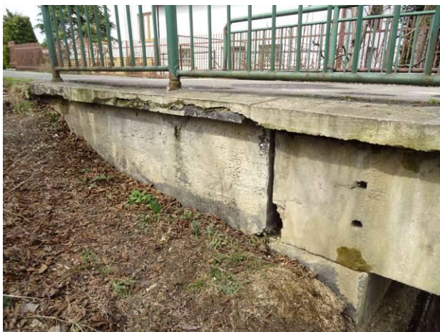
Opěra 1 – křídlo K1P. Uložení nosníků bezložiskové.
