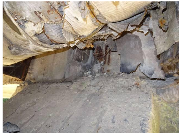
Uložení pravého nosníku na P2 vpravo.
