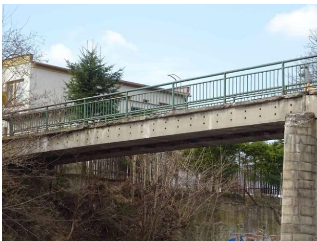
Nosná konstrukce (NK) – pole 1
