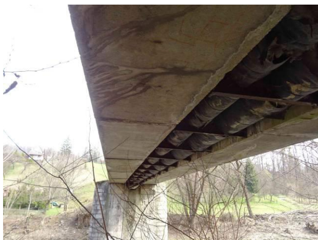
Podhled NK v poli 1
