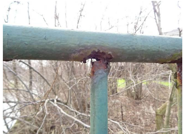
Detail foto vedle - urezlé prvky výplně zábradlí
