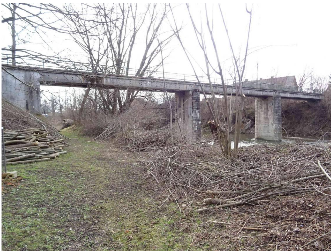
Pohled na lávku zprava (ze vtoku). Opěra OP1 je vlevo.
