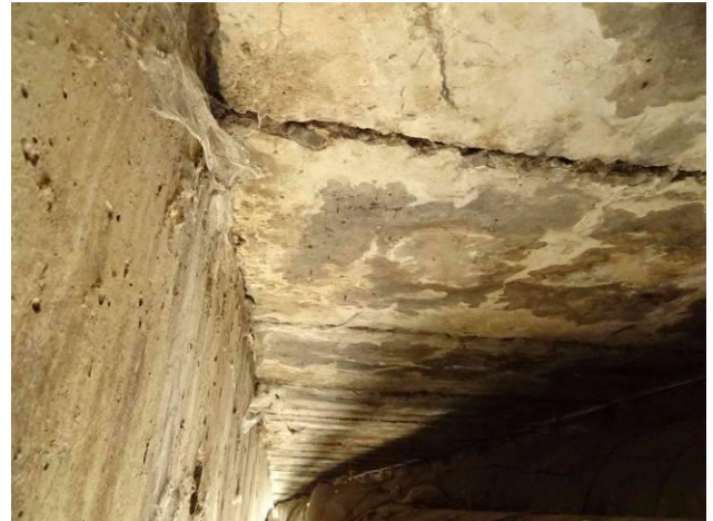
Deska mostovky před OP1
