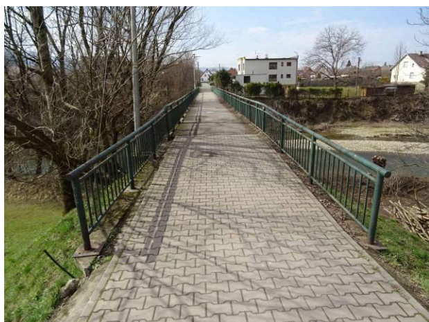
Pohled na lávku z pravého břehu, od nemocnice
