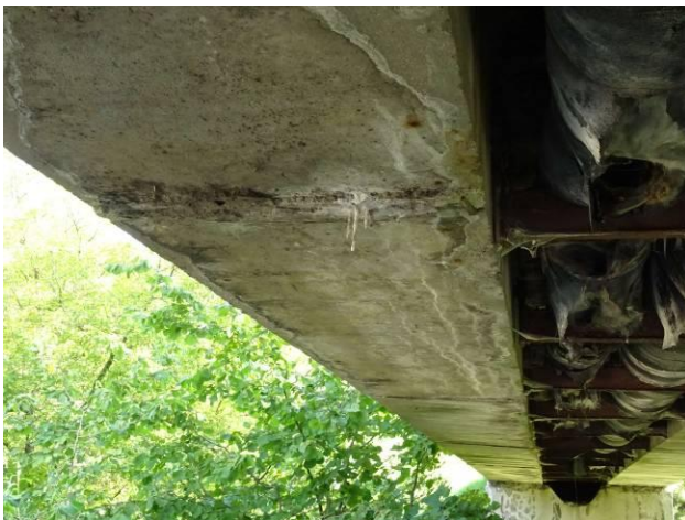
Podhled levého nosníku v poli 3.
