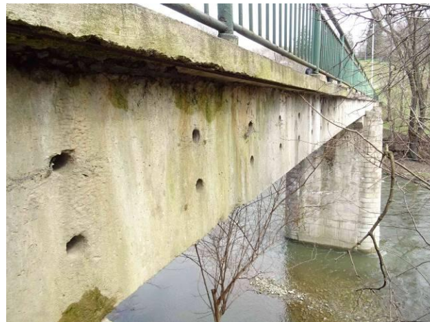
Fasáda pravého nosníku v poli 1.
