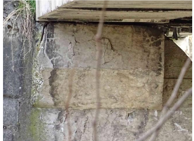
Podpěra P2, levá konzola pro uložení NK v poli 1. Odrýskává krytí.
