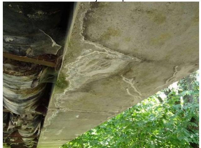
Podhled pravého nosníku v poli 3.
