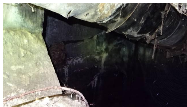
Pohled do komory OP1 – průsaky křídlem K1P
