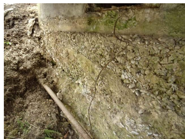
Pohled na OP1. Ve spodní části je sesutý svah před opěrou, obnažený beton je hrubý, nerovný.
