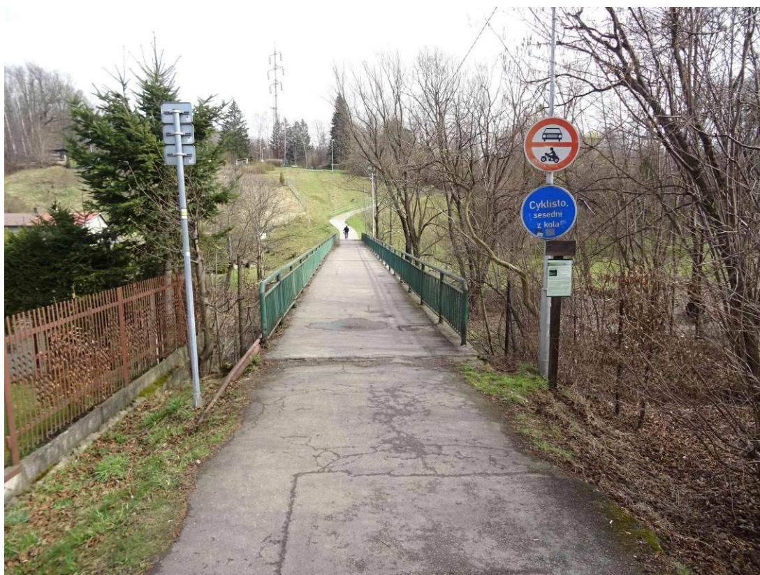
Pohled na lávku ve směru staničení směrem k nemocnici. Vtok je vpravo.
