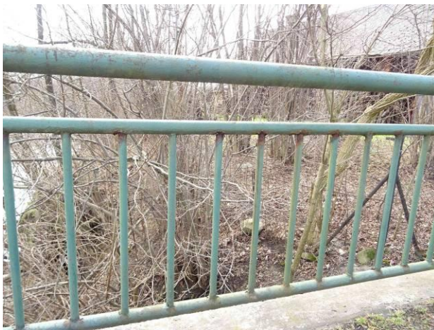
Výplň pravého zábradlí
