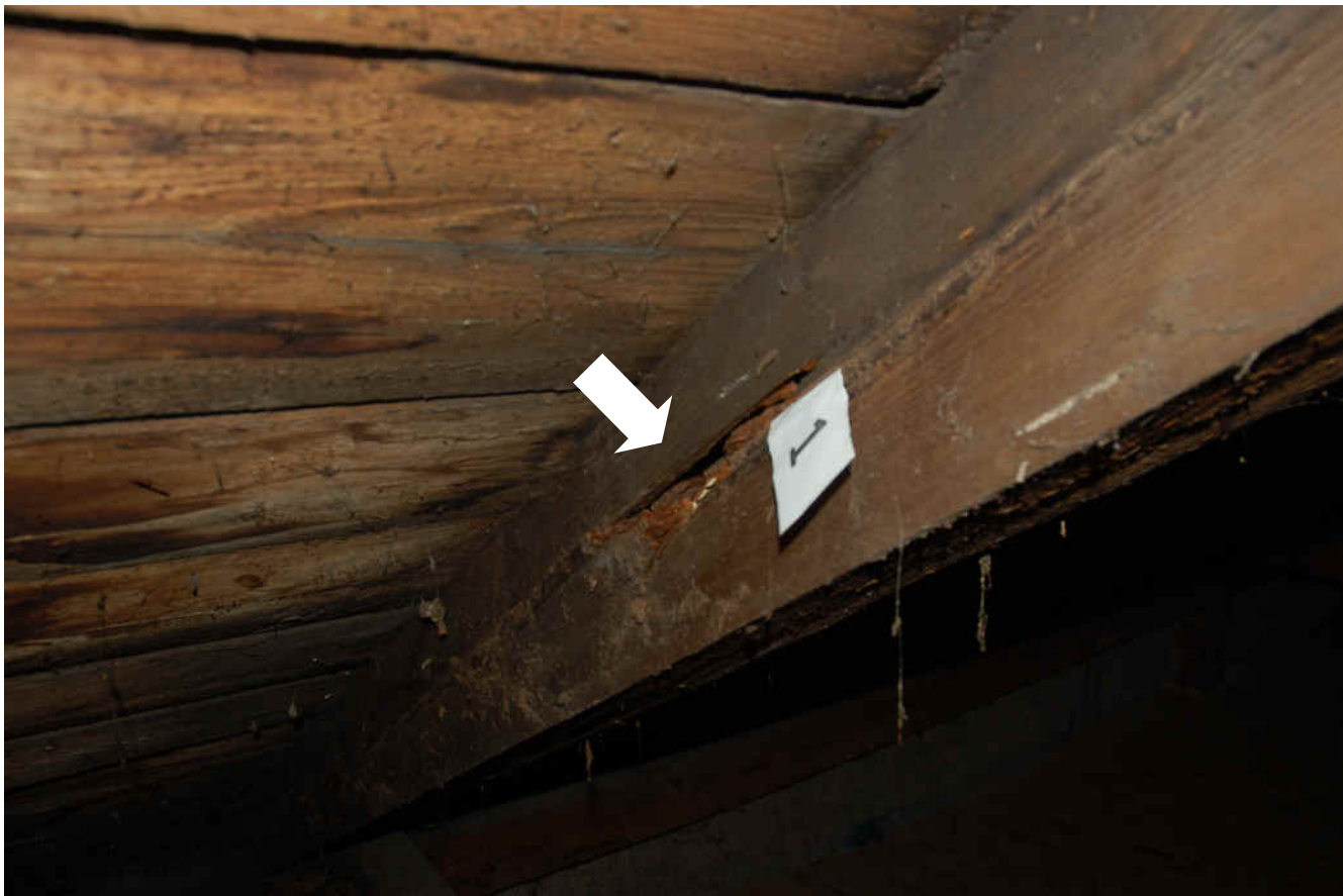
Obr. 1 Hlubková destrukce krokve hnilobou způsobenou dřevokaznou houbou z čeledi CHOROŠOVITÝCH třídy Basidiomycetes a hmyzem z čeledi ČERVOTOČOVITÝCH - stav po kontrolních vpichů.
