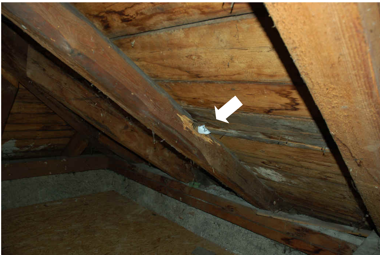
Obr. 3 Hlubkové poškození krokve K2 hmyzem z čeledi TESAŘÍKOVITÝCH - stav po kontrolních vpichů.
