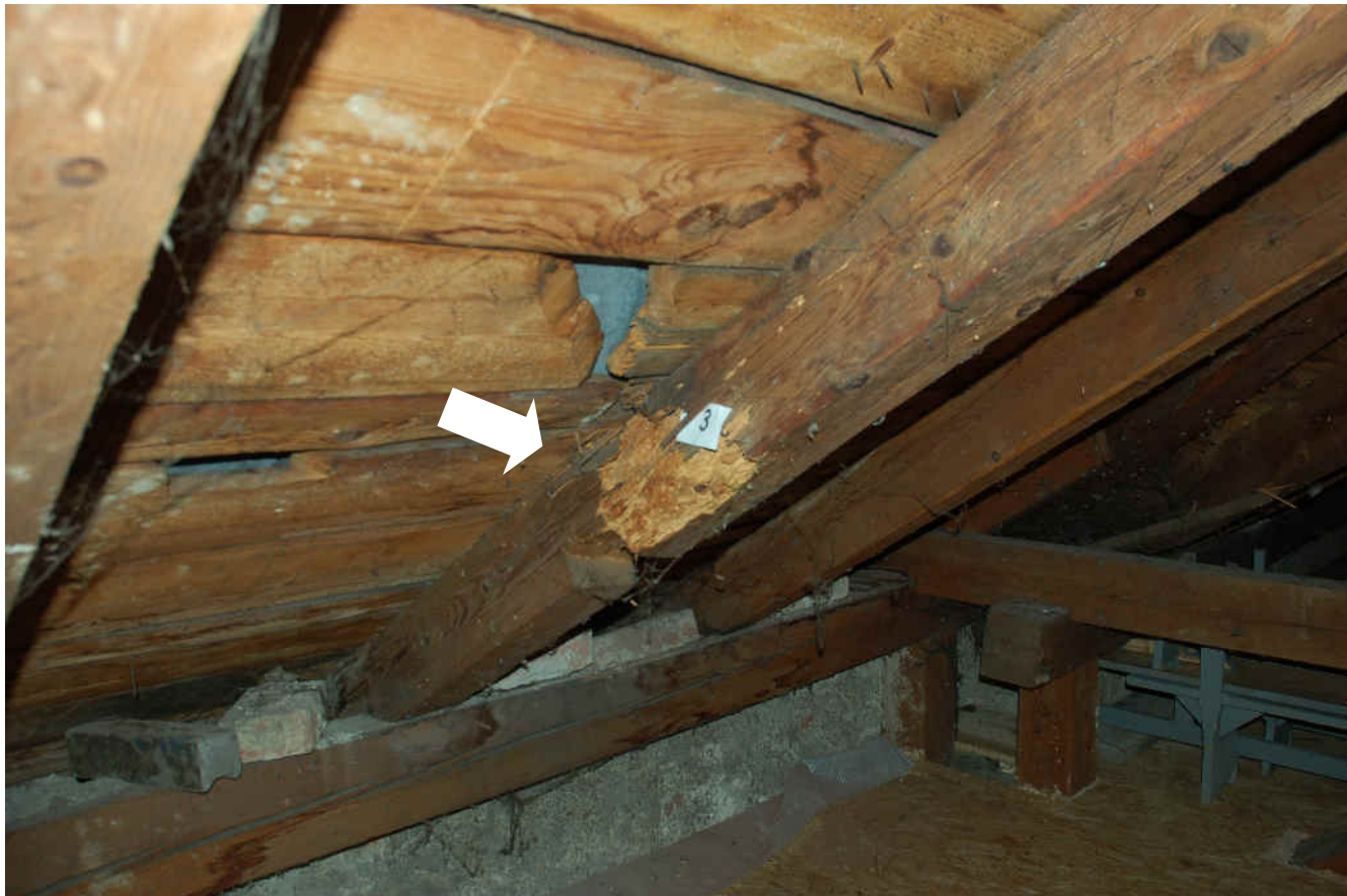
Obr. 4 Hlubkové poškození krokve K3 hmyzem z čeledi TESAŘÍKOVITÝCH - stav po kontrolních vpichů.
